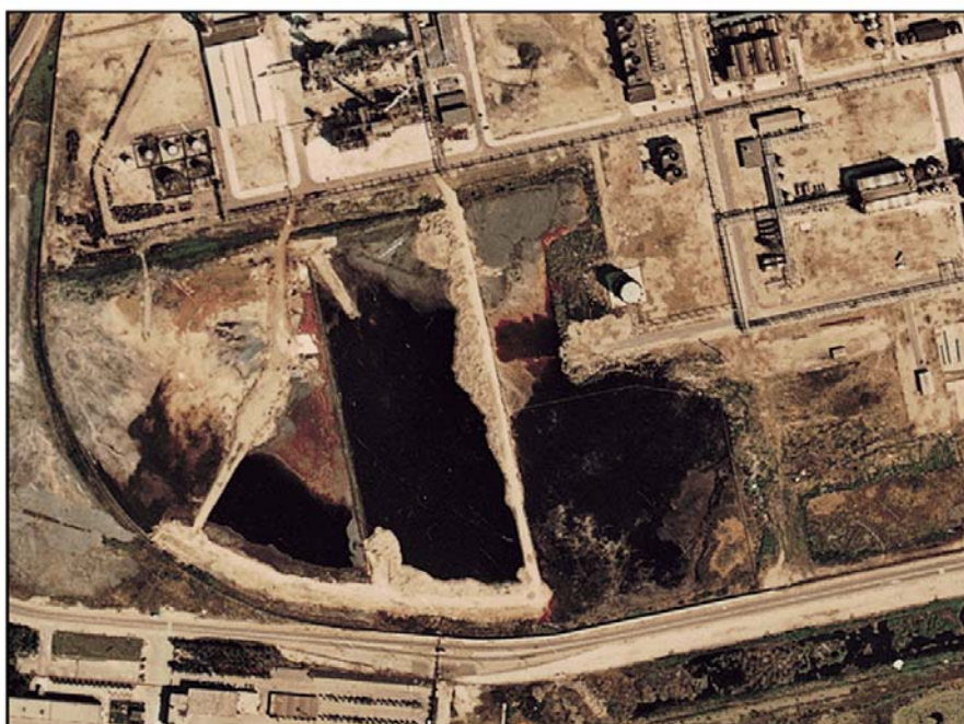
Figura 6.4: Fase di realizzazione di una discarica all'interno dell'area del Petrolchimico di Porto Marghera.
